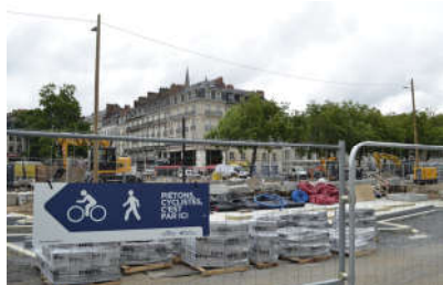
Travaux place du Commerce : une longue attente
